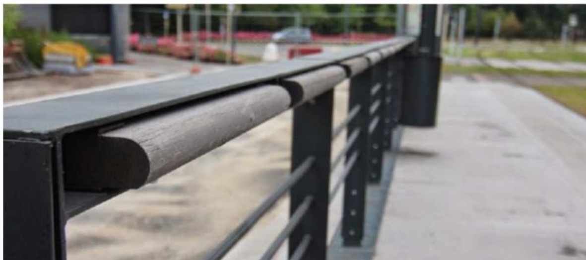
Obr. 20: príklad integrovanej opierky
